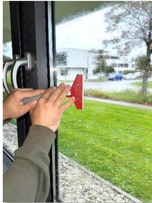
1. Zu beklebende Fläche gründlich mit **Glasreiniger** reinigen.
